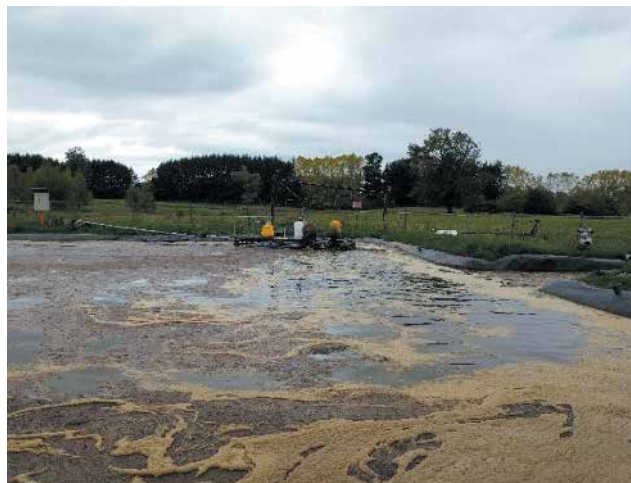
Lagunas de tratamiento con base impermeabilizada con geo membrana.
